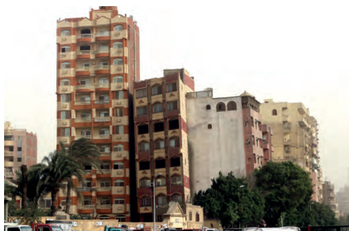
Fot. 2. Katastrofa budowlana w Kairze [Egipt 2015; źródło © A. Sawicki]
