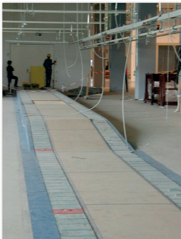
Fot. 4 Przenośnik dwutorowy w trakcie montażu. Widoczne są jego dwie wysokości.
