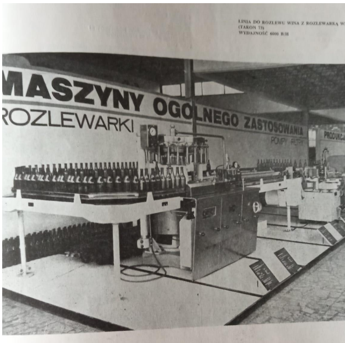
Linia do rozlewu wina z rozlewarką WRB-6 o wydajności 6000 b/h
