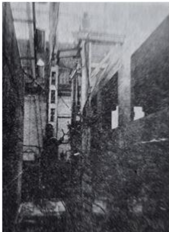
Rys. 23 Przejedny portal na stanowisku prostowania metodą płytową.
