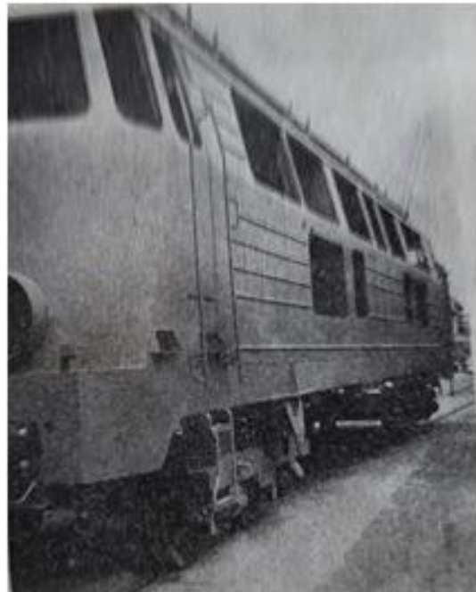
Rys. 18 Ryflowane pudło lokomotywy spalinowej typu 301 D
